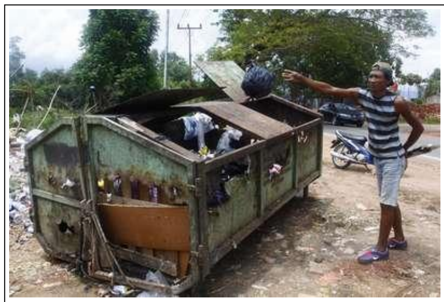
Gambar 15. Bak Sampah yang Tidak Terpelihara (Rusak Konstruksinya)
