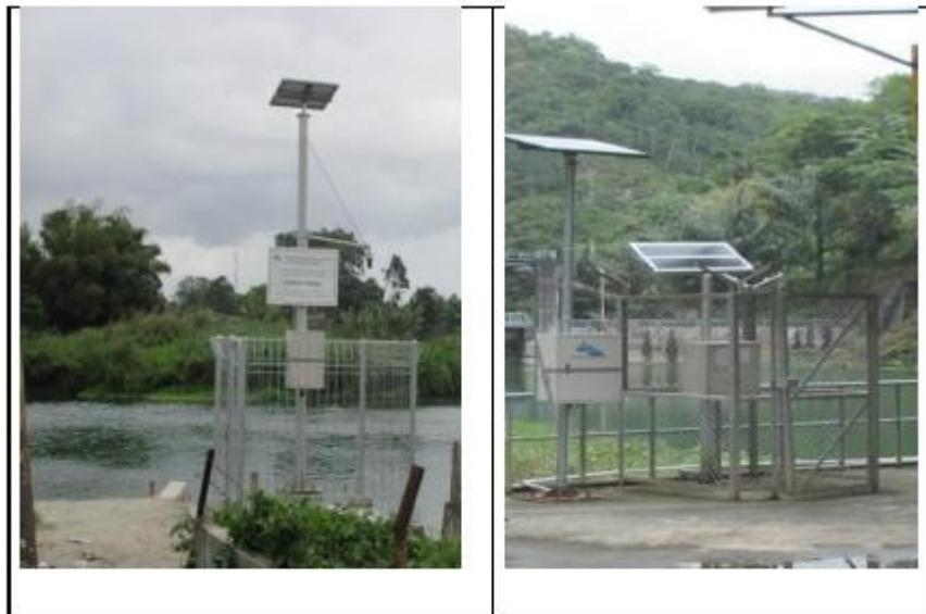
Gambar 8. Contoh Bangunan Pelindung Tidak Permanen
